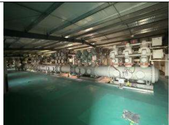
220kV 间隔预留位置
