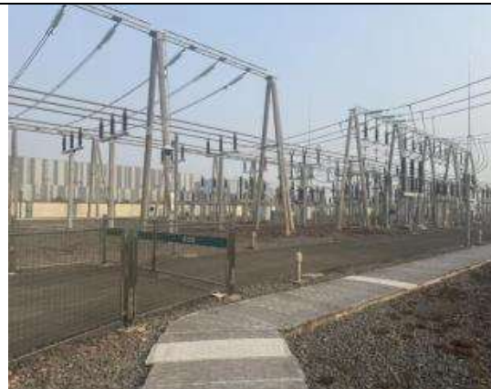
110kV 间隔预留位置
