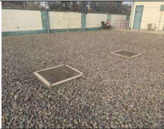
现有事故油池
