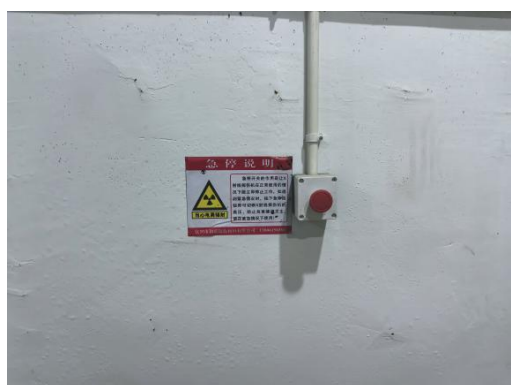
图 1 探伤室内紧急停机按钮及使用说明
