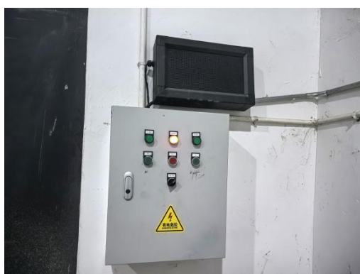
图 4 探伤室内工作状态指示灯
