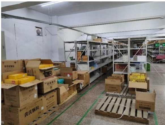
放射性药物暂存库拟建址上方 (拆零区)
