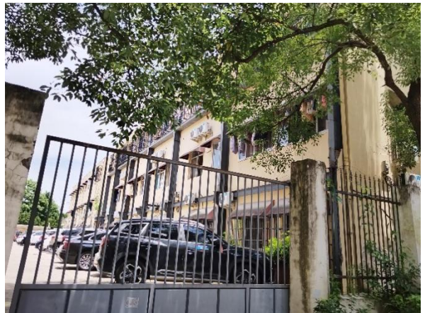
厂区北侧 11 号公寓
