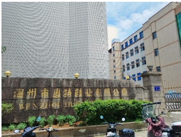
厂区西侧温州市惠特鞋业有限公司 (隔前旺路)
