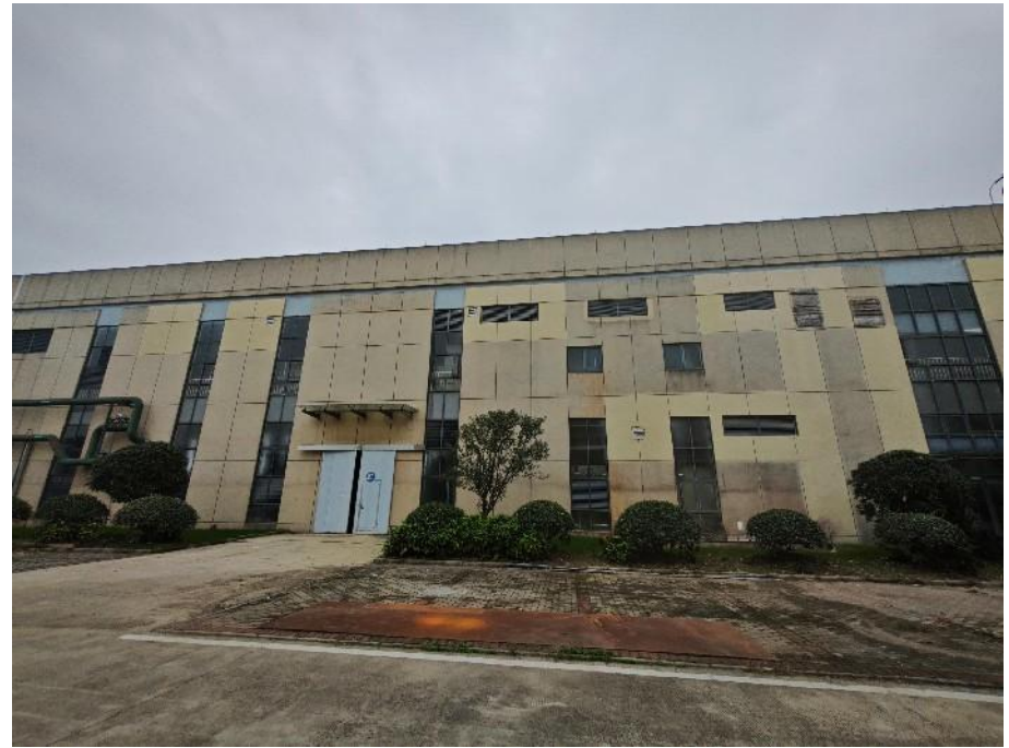
图 2 6#楼（中试线车间）
