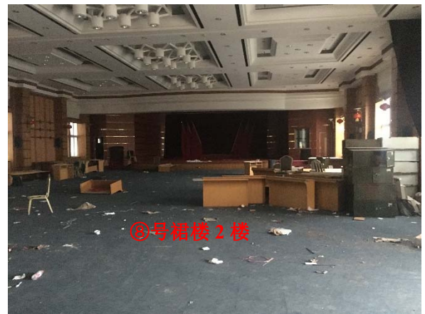
图 8-4 本项目拟建址楼上现状
