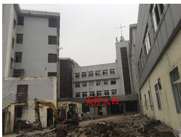
图 8-1 公司大厅入口现状
