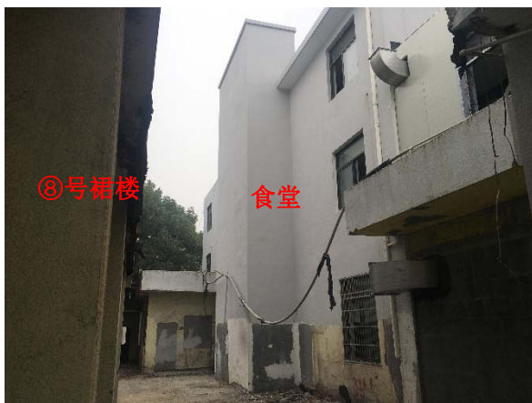
图 8-7 ⑧号裙楼西侧
