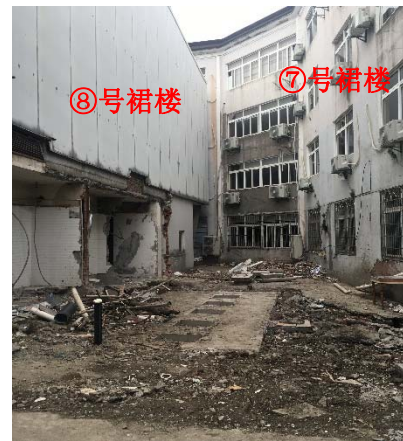
图 8-6 ⑧号裙楼南侧
