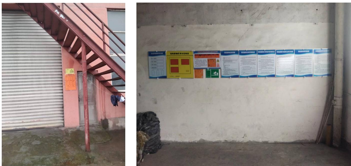
图 4-4 项目危废仓库照片
