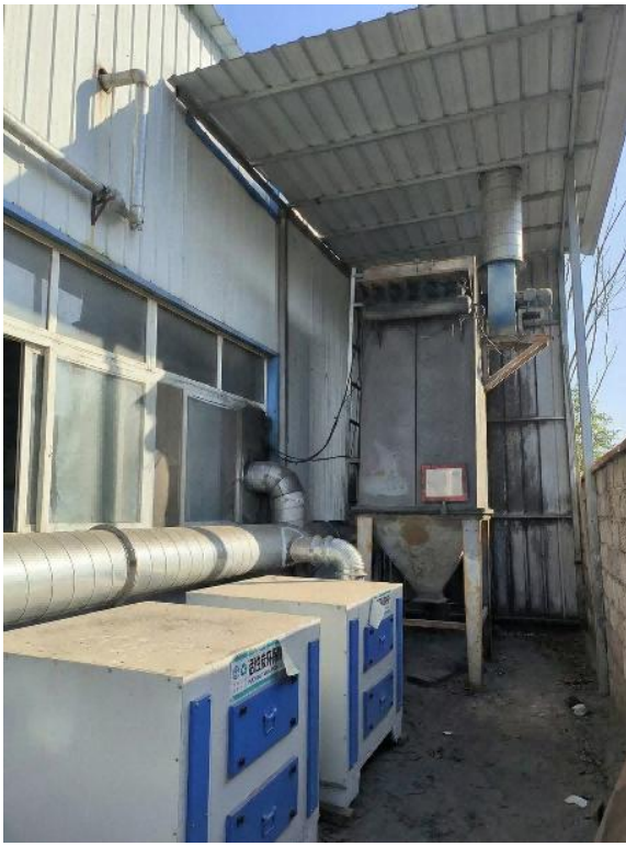
固化废气、喷塑废气处理设施+排气筒
