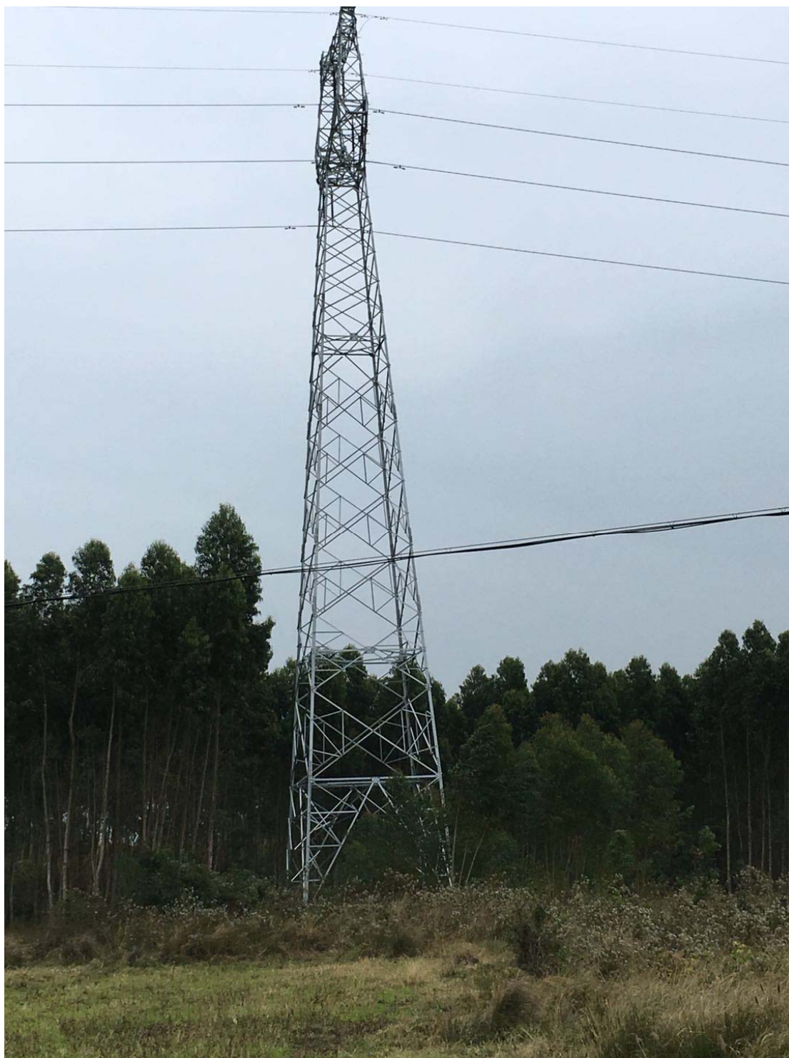
线路工程区塔基绿化（2018.4）
