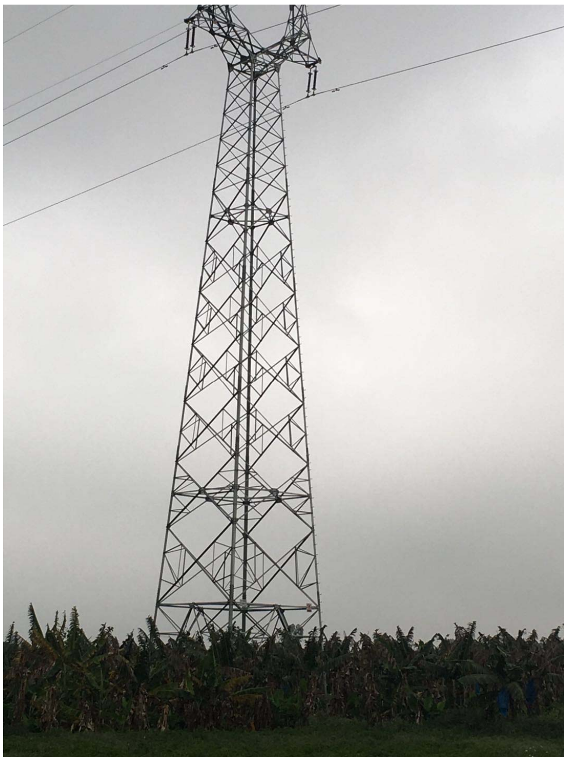
线路工程区塔基绿化（2018.4）
